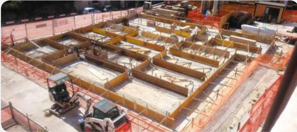
Lavori per la costruzione del nuovo edificio di "CASA ZACCHEO" e della nuova sede della Caritas diocesana, in via Porta Romana a Sulmona, sono partiti. Sono stati realizzati i pilastri in cemento armato a dieci metri di profondità e messe in opera le piattaforme in cemento armato sui pilastri per poter procedere alla costruzione. Casa Zaccheo, come tanti già sanno, è un'opera che la Diocesi intende realizzare come
